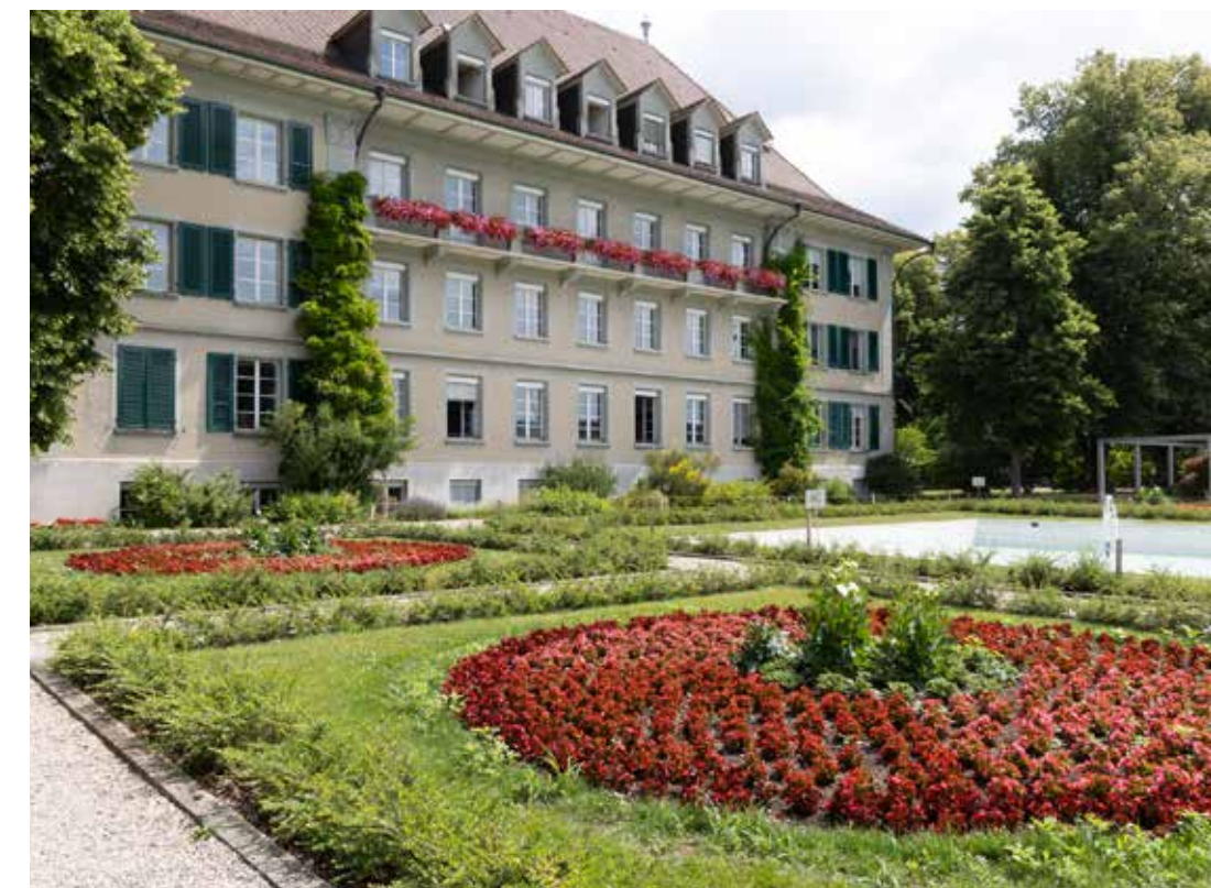
Das Schulhaus der Gartenbauschule wurde 1922 in Betrieb genommen. Noch heute findet der theoretische Unterricht hier statt. Im Vordergrund die Gartenanlage im barocken Stil.
