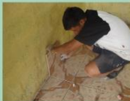
Bild: der neue Keramikboden wird verlegt.
