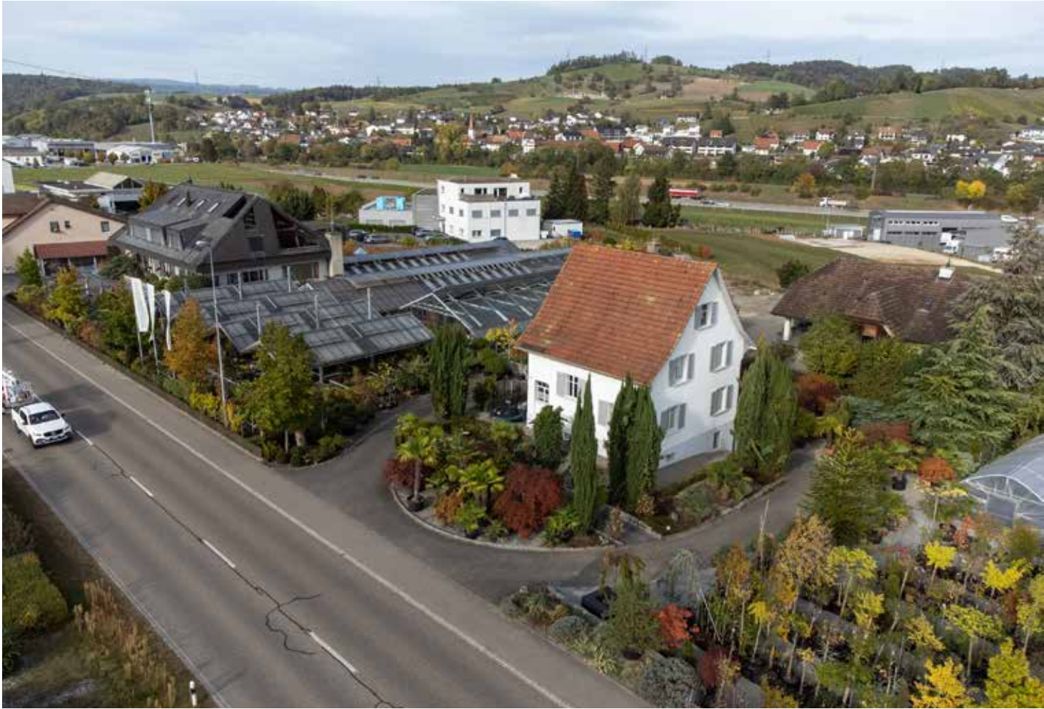
L'entreprise vue du ciel. Elle s'étend sur 5000 mètres carrés et comprend trois bâtiments. Au premier plan, la maison d'habitation datant des débuts de la pépinière fondée en 1912. En bas à droite, la pépinière, qui ne joue aujourd'hui plus qu'un rôle secondaire.
